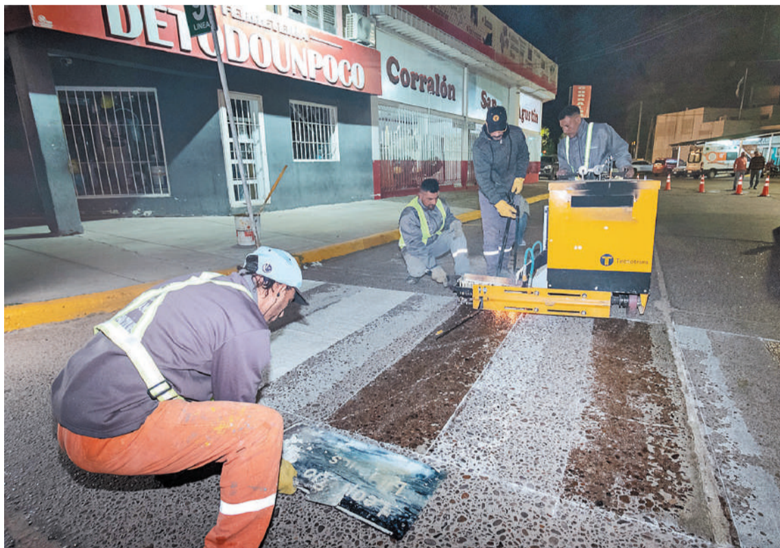
Los trabajos incluyeron la demarcación de sendas peatonales.
