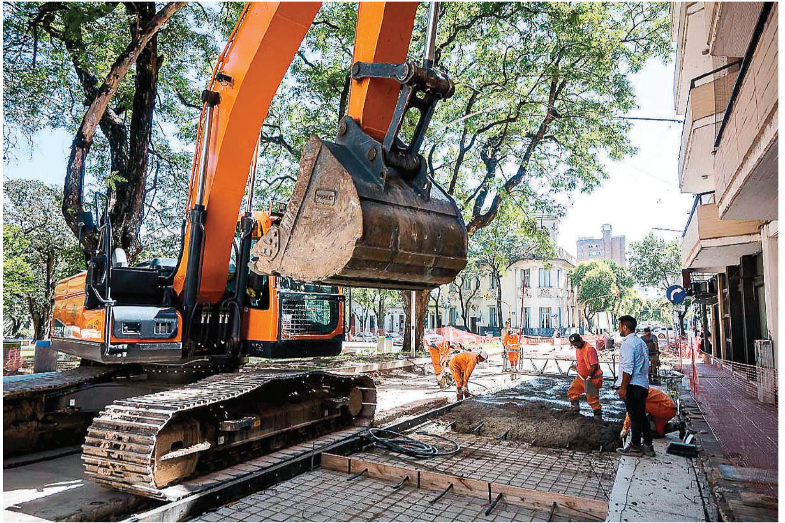
La Municipalidad intensificó este jueves las tareas de recomposición de la calzada en calle Santa Fe, entre Laprida y Alameda de la Federación.
